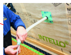
Bouchon d'étanchéité pour l'intérieur des câbles
