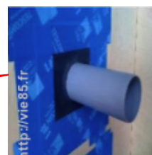
Manchettes d'étanchéité pour points de passage de câbles ou tubes
